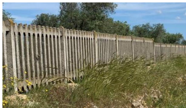
Recinzione tipo C – Elementi prefabbricati in c.a.
